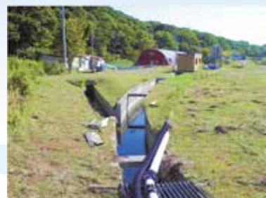
沙流ふ化場放水路
