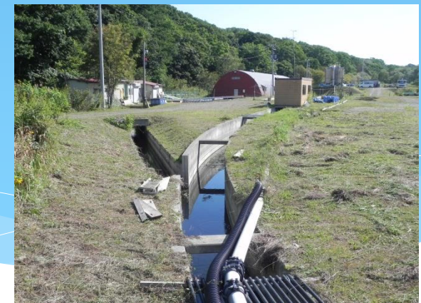
沙流ふ化場放水路
