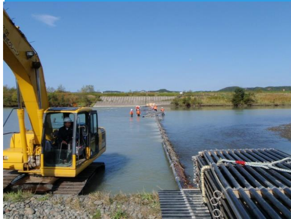
沙流川捕獲施設設置・・・川幅120m(平成28年度撤去)
