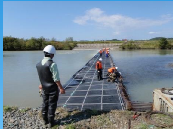
沙流川捕獲施設設置・・・川幅120m(平成28年度撤去)
